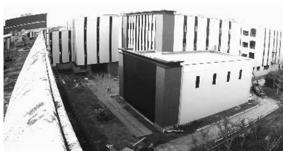
工事の様子(校舎)
