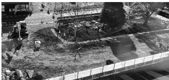
工事の様子(バスロータリー)
